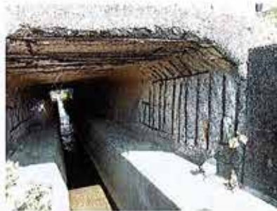
ボックスカルバートの補修・補強
