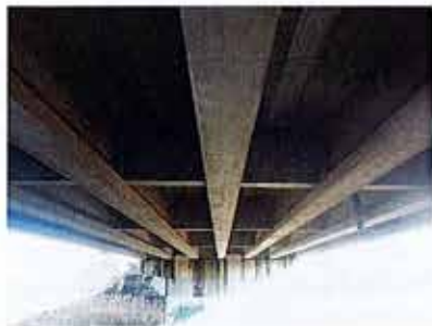
桁・床版(橋梁)の補修・補強
