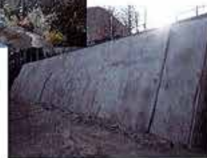
越流堰の補修
